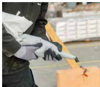
Foto 2b: foutief gebruik spuitzak
