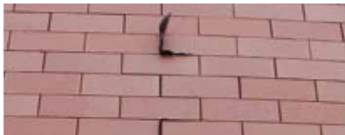
Foto 14: folie ter hoogte van de dilatatievoeg bij het optrekken van de gevel
