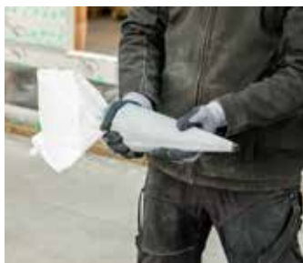
Foto 2a: correct gebruik spuitzak
