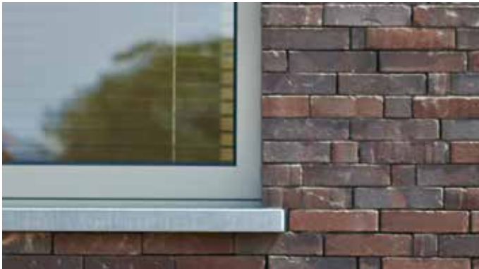
Foto 1: gevel afgewerkt met lijmmortel
