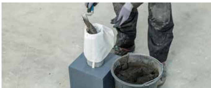
Foto 4: vullen van de spuitzak
