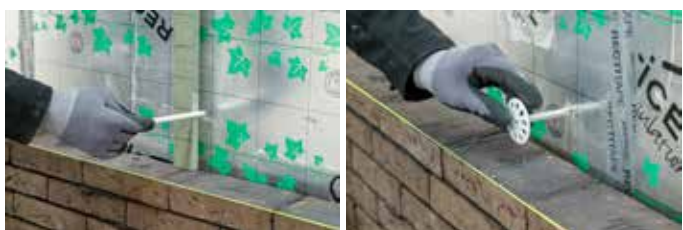
Foto 12 en 13: plaatsing spouwankers
