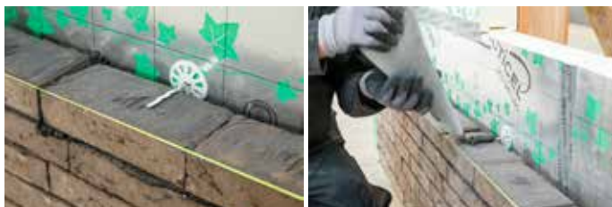
Foto 10 en 11: correct inbedden van het spouwanker
