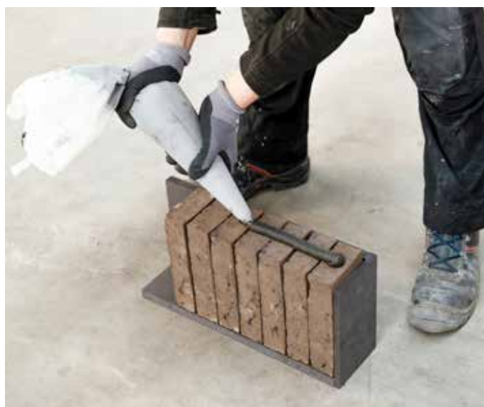
Foto 9: gebruik van een mal voor het aanbrengen van lijm op de koppen
